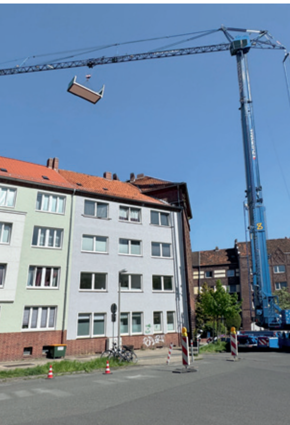
Hannover Auf dem Brinke 18 Rückfront, oben im alten Zustand, unten Montage der Balkone
