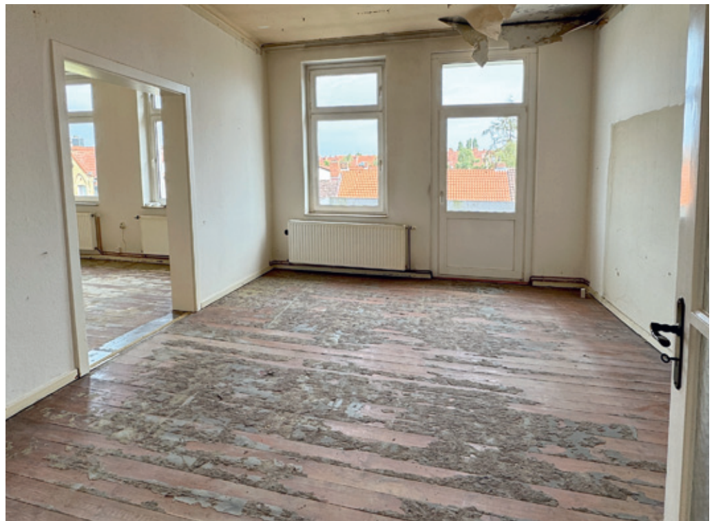
Hannover, Holscherstr. 13, 3. OG links Wohnzimmer vor der Sanierung
