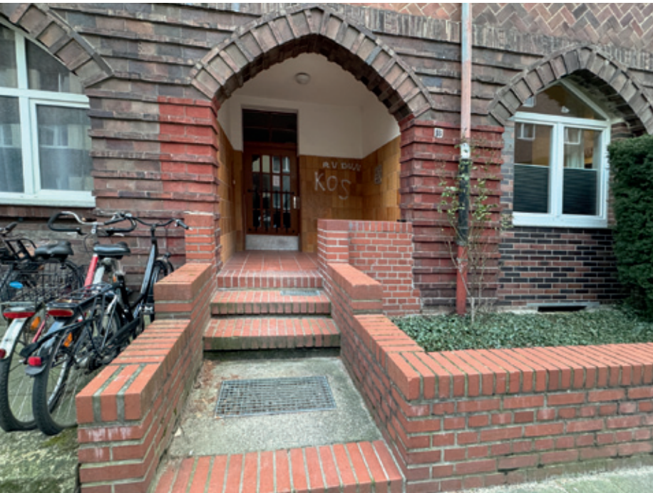
Hannover Auf dem Brinke 18 Hauseingang im alten Zustand
