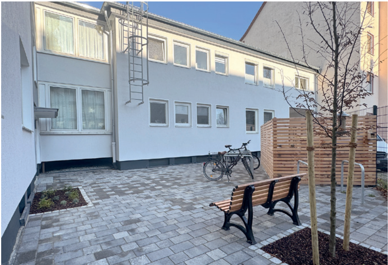
Hannover, Vahrenwalder Str. 40 Innenhof nach der Sanierung
