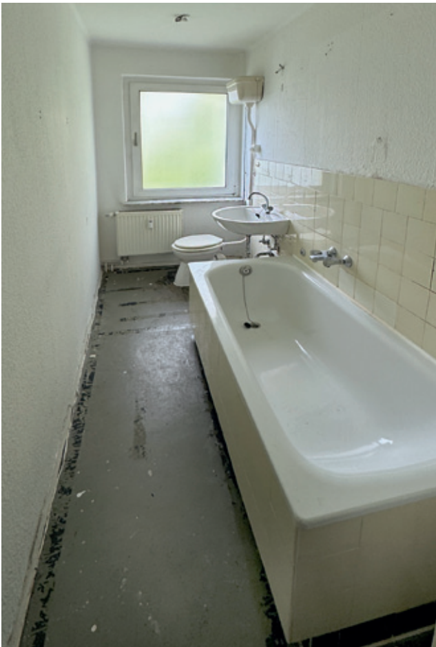
Hannover, Seestr. 11, 2. OG Mitte Bad vor der Sanierung
