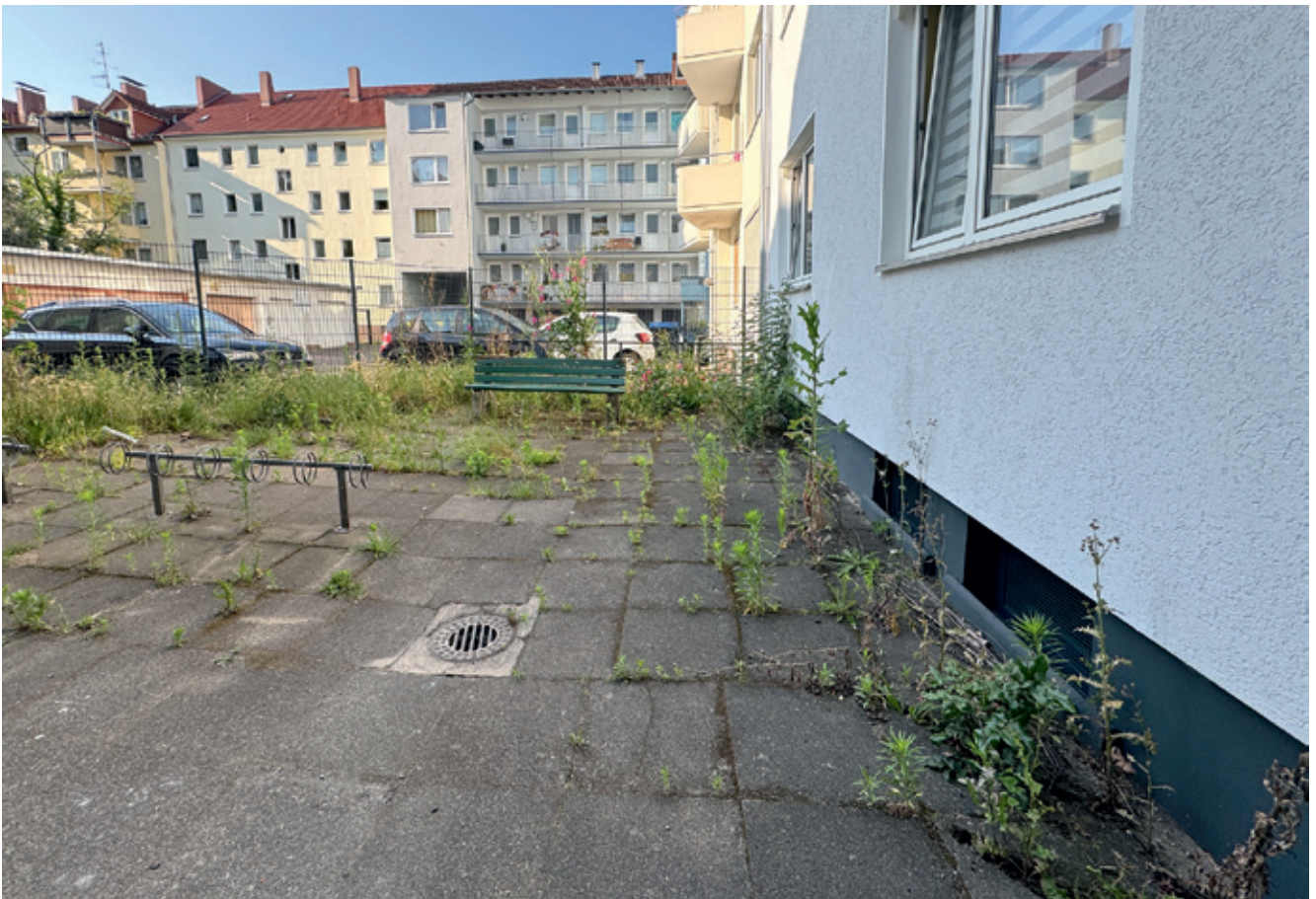
Hannover, Vahrenwalder Str. 40 Innenhof vor der Sanierung
